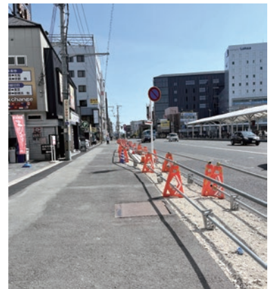
▲JR 奈良駅東口付近の奈良橿原線 県が推進している歩道整備の様子
